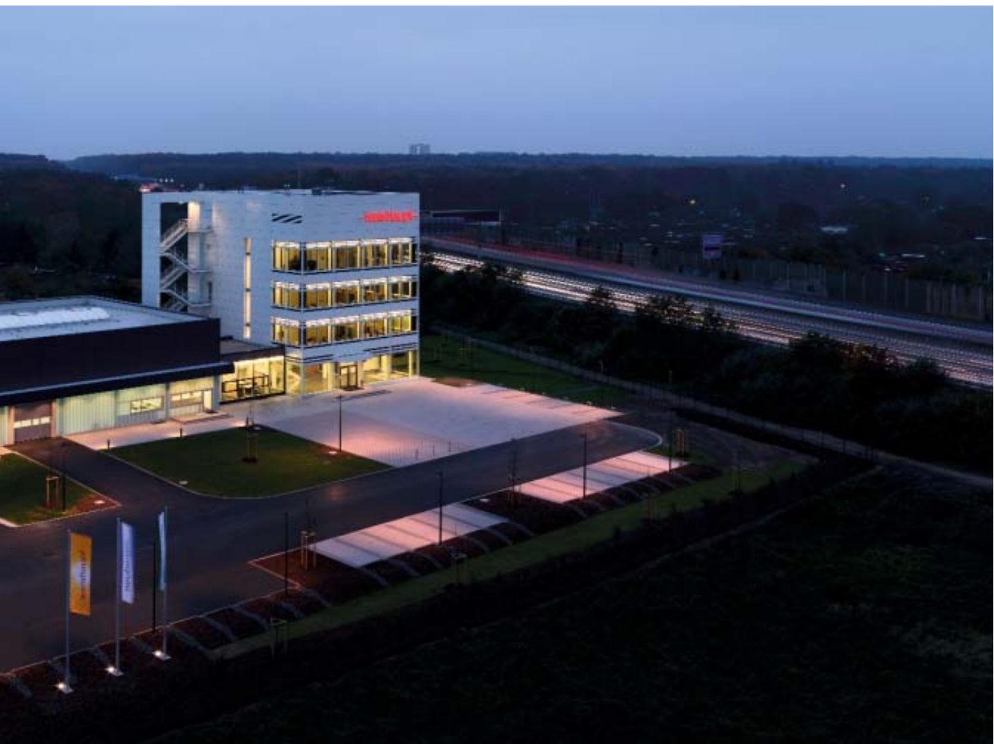
Weithin sichtbar: Die Niederlassung Frankfurt, direkt an einer der meistbefahrenen Autobahnen Deutschlands, der A5. Entworfen vom Münchner Architekten Wolfram Wöhr.
