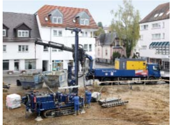
Komplett Weishaupt: Die Tochter BauGrund Süd übernimmt die Bohrungen für den Wärmepumpen-Einsatz.
